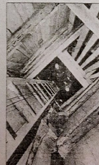
Sechs Meter tief ist der Schacht auf dem Altmarkt in Lichtenstein.
